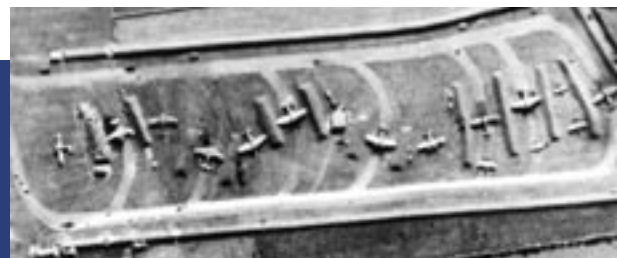
Mit Wällen geschützte Abstellflächen auf dem Flugplatz Schauendahl
